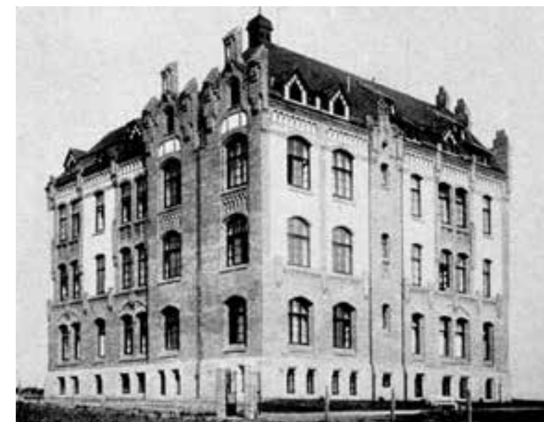
Bürgerengagement in Stein gemeißelt: Der erste Bauabschnitt (1904)
